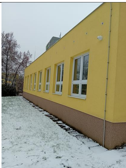
Venkovní kamera 6 – budova B
