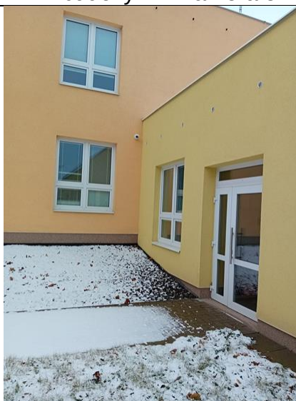
Venkovní kamera 7 – budova A+B
