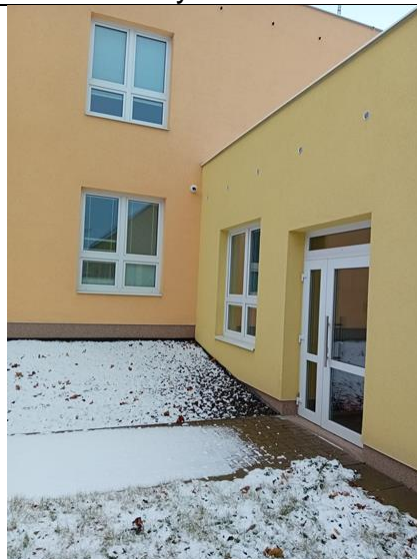
Venkovní kamera 7 – budova A+B
